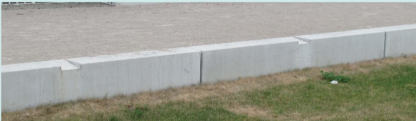
Dažďová voda je pomocou špeciálnych tvarnic zvedená priamo do trávnikov a záhonov. Viedeň, Rakúsko, Foto Mária Bihúňová
