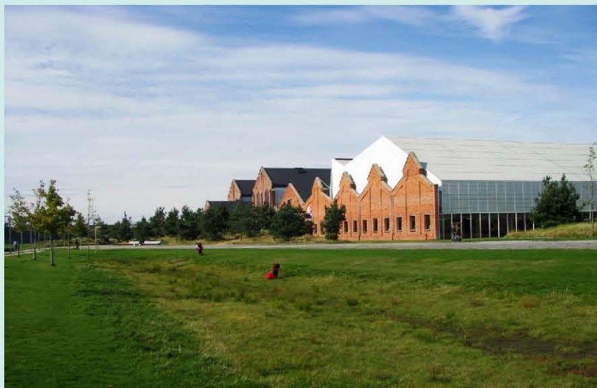
Príklad trávnatého swejlu pred a po daždi - Park Spoor Noord v Antverpách, Belgicko, Foto Jana Hlavová
