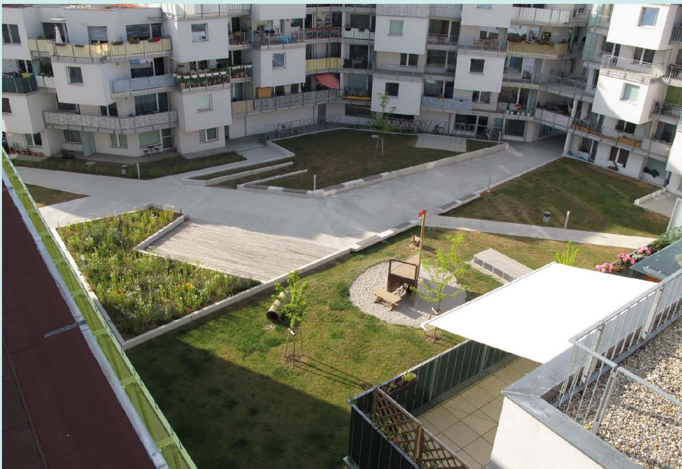
Dažďová voda je pomocou špeciálnych tvarnic zvedená priamo do trávnikov a záhonov. Viedeň, Rakúsko, Foto Mária Bihúňová
