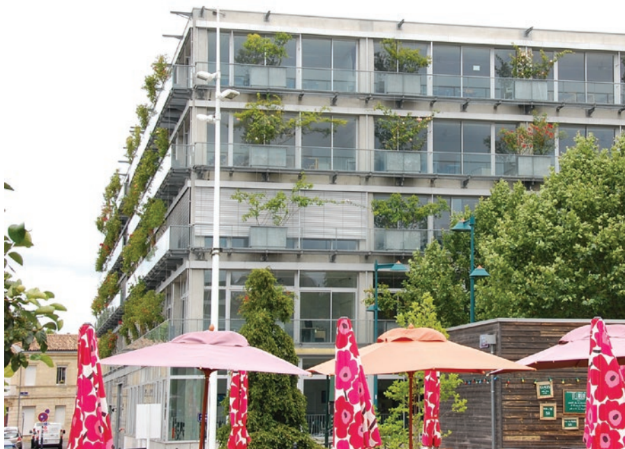
Foto 5: Príklady zelenej infraštruktúry - zeleň na balkónoch a terasách
