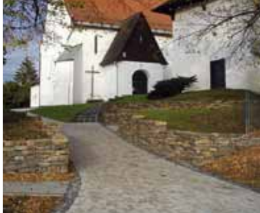
Kamenné múriky ukladané bez malty umožňujú v špárach rast skalkovitým a suchomilným rastlinám
