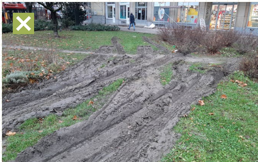
09 Pri stavebných prácach neboli použité vozňové dosky alebo panely na prejazd ťažkej techniky, vďaka ktorým by sa predišlo zhrutneniu a devastácii pôdneho horizontu. Bratislava, Krížna ulica
