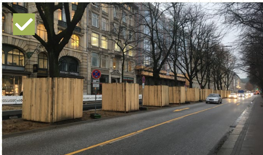
06 Kmeň stromu je „chránený“ debnením proti mechanickému poškodeniu. Priestor vnútri debnenia nie je vyplnený materiálom tlmiacim náraz a drenážou. Hamburg, Nemecko
